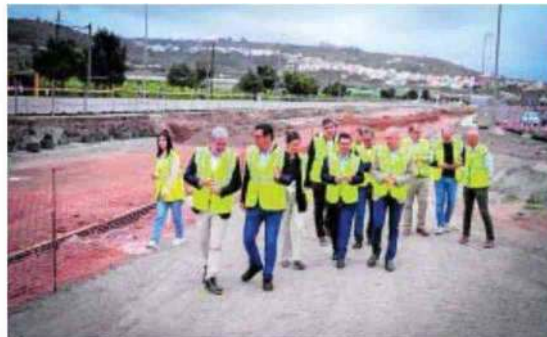
Las autoridades visitaron ayer el estado de la obra. c7
